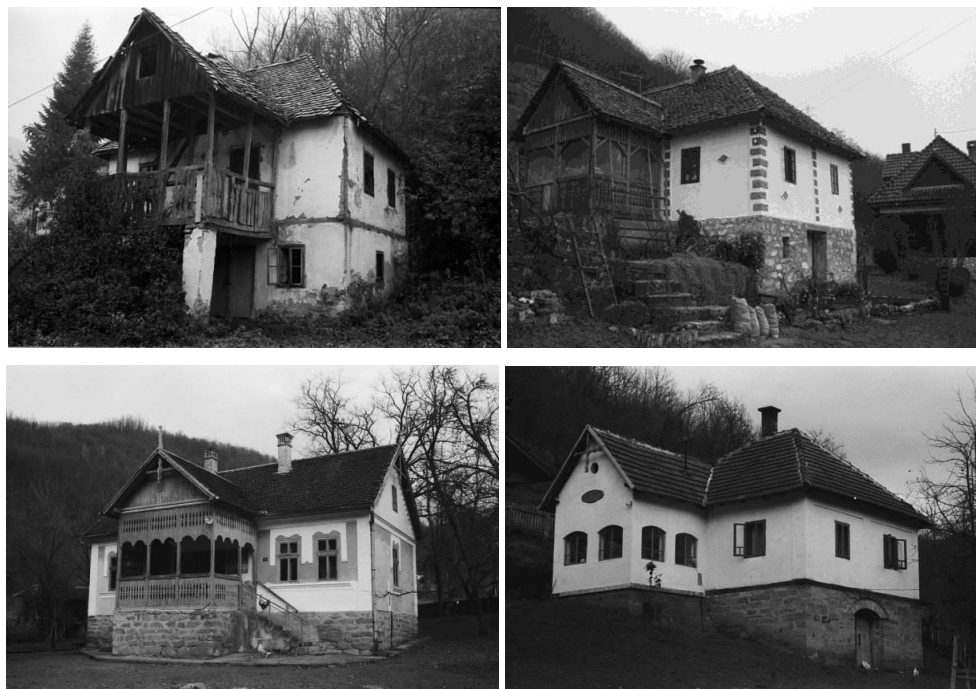
Слика 1. Кућа са тремом на дугој страни фасаде. Четири варијанте структурног решења у складу са временом, расположивим материјалом и могућностима власника. Бајина Башта и Љубовија (2000).
