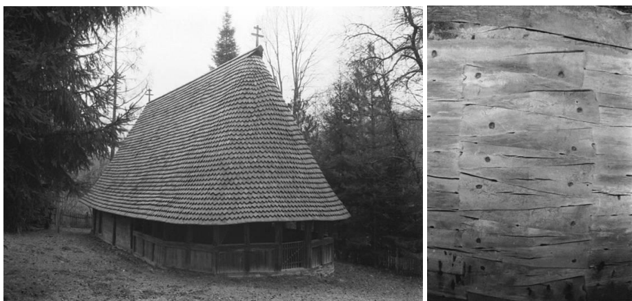
Слика 3. Сакрални објекти су грађени уз коришћење принципа традиционалне архитектуре. Црква у Дубу код Бајине Баште, детаљ: везе брвана на апсиди. Порекло: аутор.
